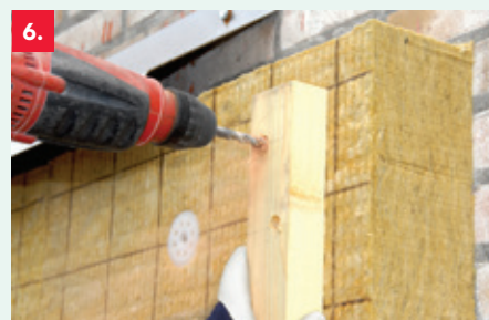
6. Boor het gat in de wand door de ROCKWOOL isolatie heen.
