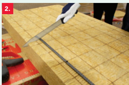
2. Snijd de ROCKWOOL isolatie op maat.
