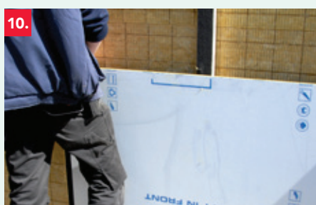
10. Bevestig de gevelbekleding.
