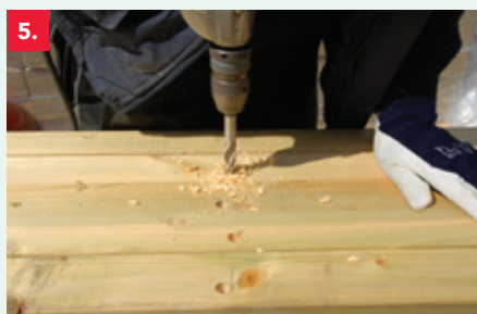
5. Boor de houten regel voor.
