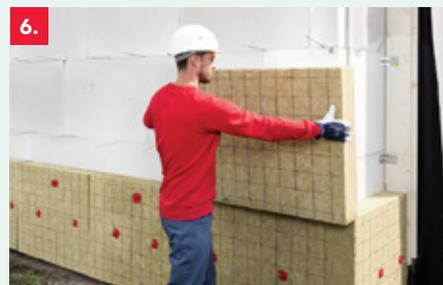
6. Débutez la seconde rangée en veillant à ce que l'angle extérieur soit réalisé en appareillage alterné par rapport à la première rangée.
