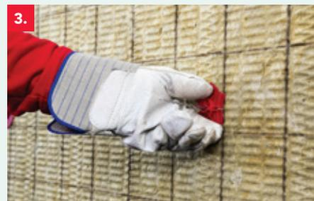
3. Insérez les clips sur les ancrages et compressez-les contre l'isolant.
