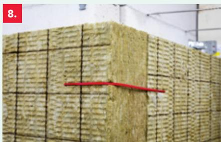
8. Si le raccord vertical entre les panneaux d'isolation n'est pas parfaitement jointif à hauteur de l'angle extérieur en raison d'un support irrégulier, forcez-le en place au moyen de la cornière Rocktect Corner Strip. Posez une cornière par section de 30 cm de hauteur (au moins 2 éléments par hauteur de panneau).
