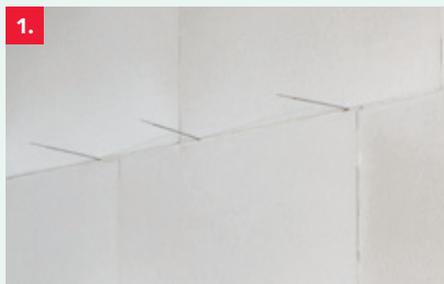
1. Utilisez une spatule pour éliminer des irrégularités les plus grossières de la face externe de l'enveloppe intérieure. Dépliez à l'horizontale les ancrages insérés dans les joints de mortier ou de colle de l'enveloppe intérieure et assurez-vous que la première rangée de panneaux isolants soit posée parfaitement de niveau.
