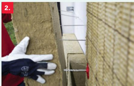
2. Disposez les panneaux d'isolation à l'horizontale. Si vous utilisez Rockfit Duo ou Rockfit silver, orientez la face dure ou revêtue vers l'extérieur. Glissez toujours les panneaux bien perpendiculairement sur les ancrages et appuyez-les contre le support.
