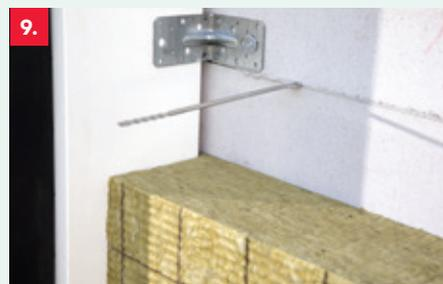
9. À hauteur des ruptures verticales et horizontales (pour les portes ou les ébrasements, par exemple), découpez un empiècement plus large de quelques millimètres afin d'assurer une bonne jonction par serrage. Au niveau des éléments faisant saillie de l'enveloppe intérieure (canalisations, par exemple), pratiquez une découpe dans le panneau isolant.
