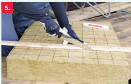
5. Si tel n'est pas le cas, découpez un empiècement de largeur adaptée à l'aide de la règle de coupe et du Rocktect Knife et disposez-le en avant-dernière position. Cet empiècement doit être fixé au moyen de 2 ancrages minimum.
