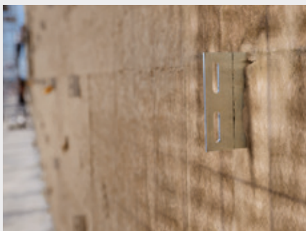
Système de fixation traditionnel en aluminium
