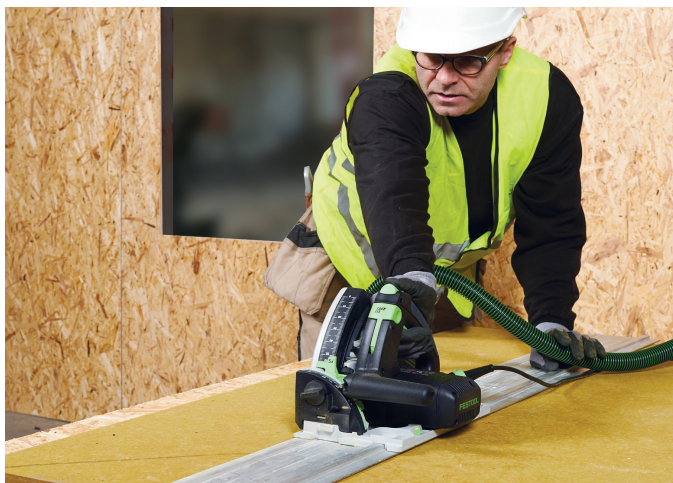
REDAir Link -levyn työstämiseen ei tarvita erikoistyökaluja, vaan tavalliset työkalut riittävät.
