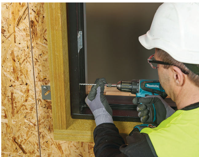
Ikkunoiden asennus REDAir Link Board -levyyn karkeakierteisillä kevytbetoniruuvilla.
