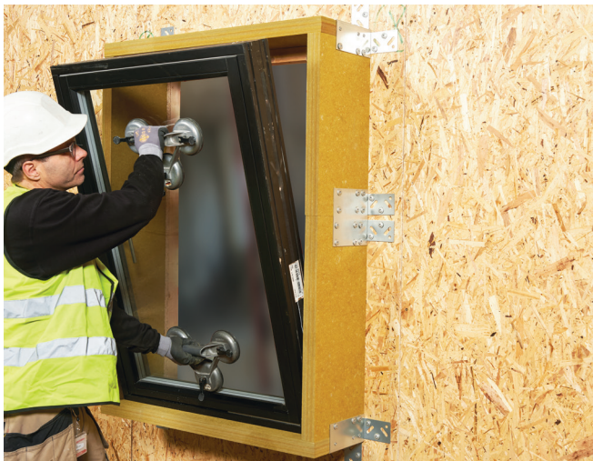
Ikkuna nostetaan paikalleen REDAir Link -kehykseen.
