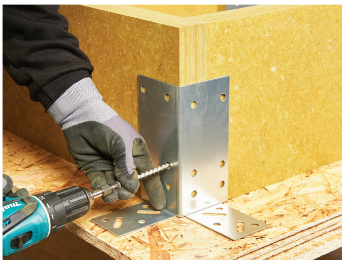
Asennus tehdään REDAir Link -kulmakiinnikkeellä ja mukana toimitetulla
