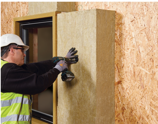
REDAir-järjestelmän (RedAir Batts) asennus REDAir Link Boardin ympärille.
