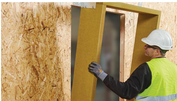
REDAir Link nostetaan paikalleen.
