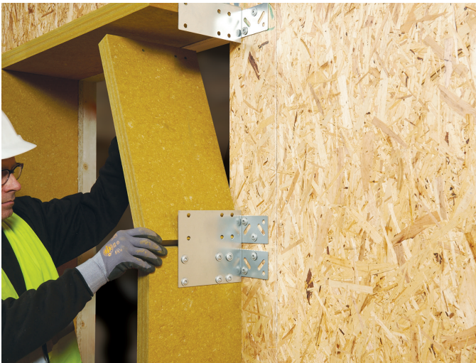
REDAir Link -levy kiinnitetään esiasennettuihin kiinnikkeisiin.
