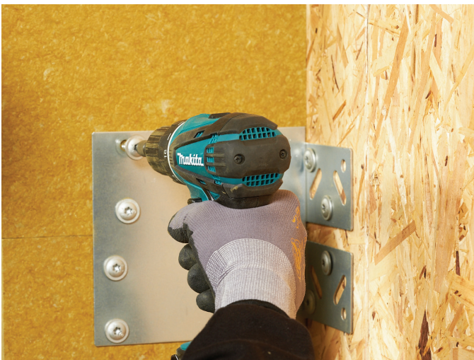
Jatkokiinnike levyn jatkokohdassa.
