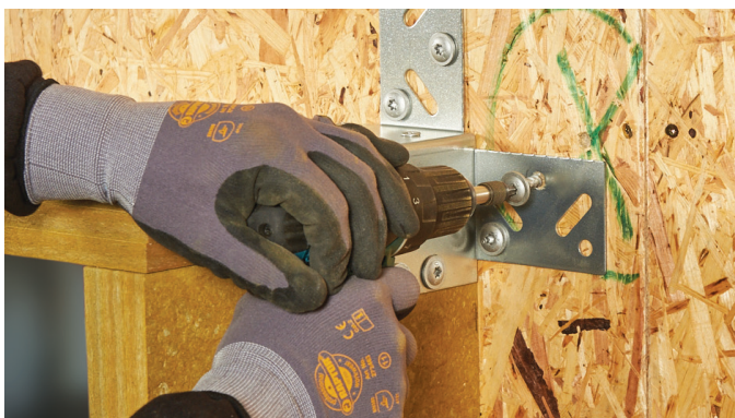
REDAir Link -järjestelmä kiinnitetään seinään kulmakiinnikkeistään kohdekohtaisilla ruuveilla.
