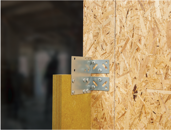
REDAir Link -liitoskiinnikkeet asennetaan seinälle.
