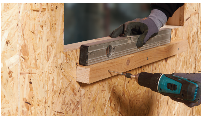
Esimerkki väliaikaisesti asennetusta tuesta REDAir Link Boardin tukemiseksi.
