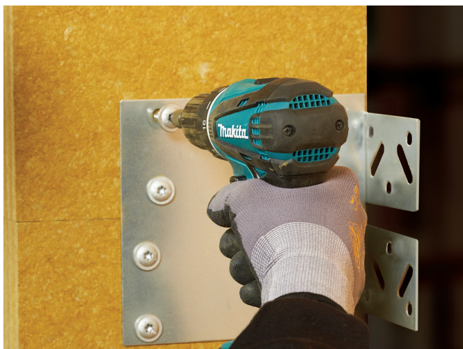
REDAir Link -jatkokiinnikettä käytetään liitosten tekemiseen.
