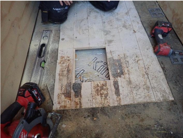
Bilde A.7 Kingspanisolerings avdekket gjennom et lite hull i taktro av 23 mm bordtak.
