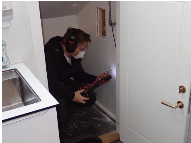
Bilde A.2 Hulltaking gjennom 2x13 mm gipsplater.
