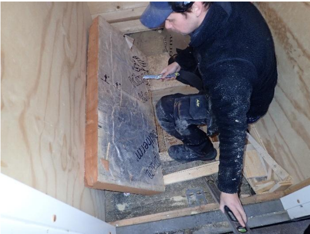
Bilde A.15 Plata ble kuttet i to.
