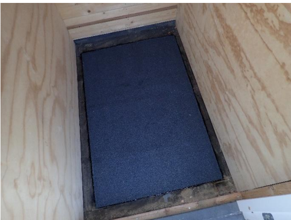
Bilde A.17 Ferdig tekktet gulv.
