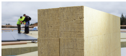
Figur 44: Udlægning af TOPROCK System på ståltrapez.
