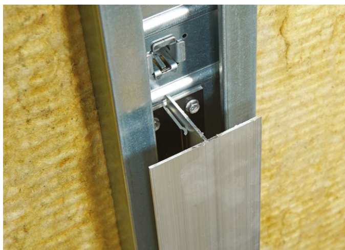
Billedet viser T-profilen i den maksimalt ujusterede position.
