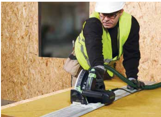
Tilskæring af REDAir Link Board med almindeligt håndværktøj
