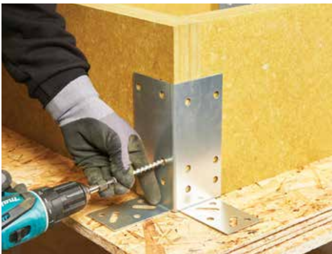
Montage af lang samleskrue ved hjørnebeslag
