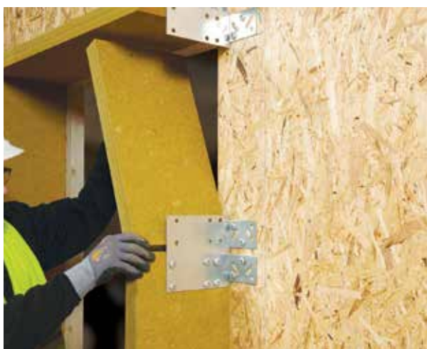
REDAir Link Board fastgøres i det formonterede beslag
