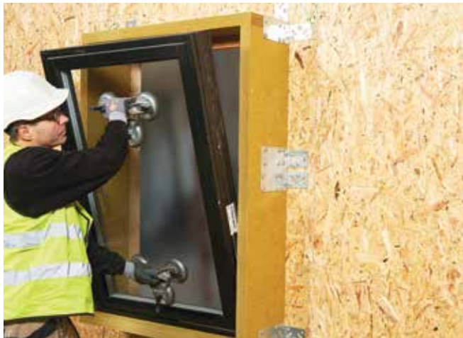
Vindue løftes på plads i REDAir Link
