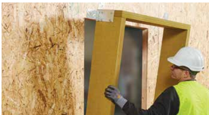
REDAir Link løftes på plads
