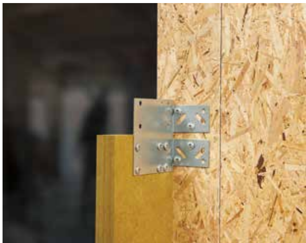
REDAir Link beslagene monteres på bagvæggen
