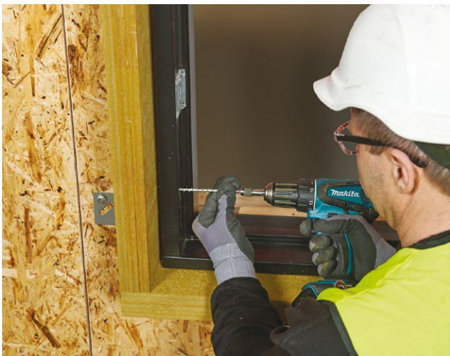
Montering af vindue i REDAir Link Board med grovgevindede letbetonskruer.
