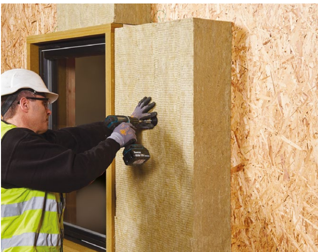
Montering af REDAir System (REDAir Batts) omkring REDAir Link Board.
