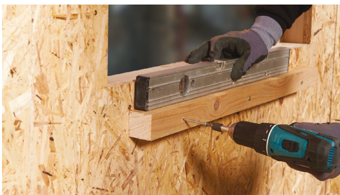
Eksempel på midlertidig skinne til understøttelse af REDAir Link Board.
