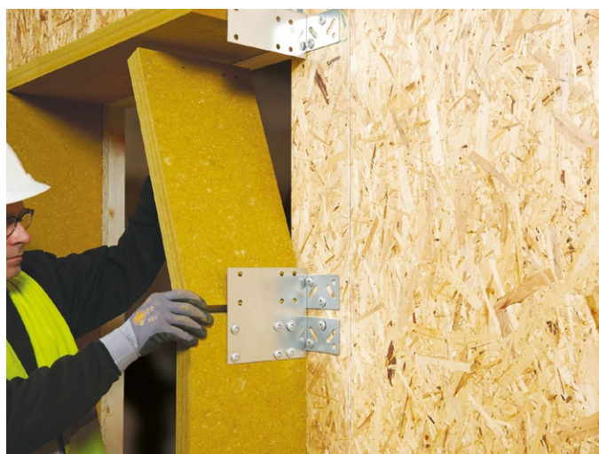
REDAir Link Board fastgøres i de formonterede beslag.
