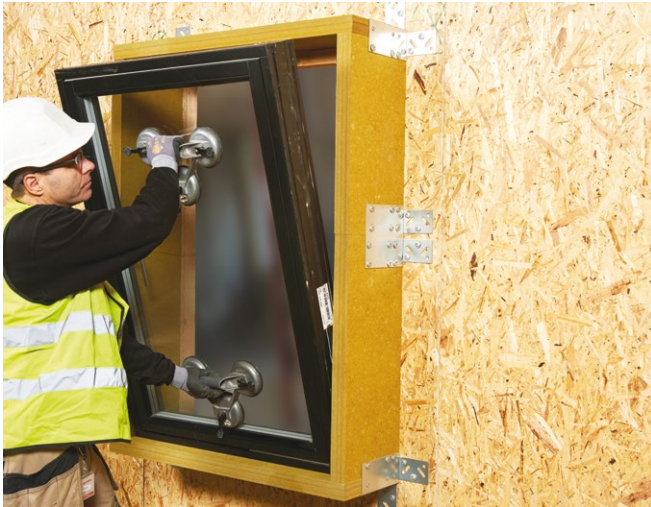
Vindue løftes på plads i REDAir Link-rammen.
