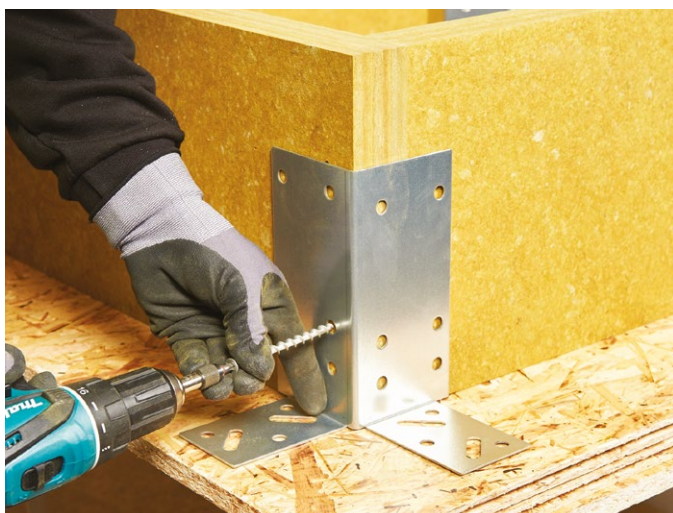
Monteringen udføres med REDAir Link Hjørnebeslag og medfølgende skruer.
