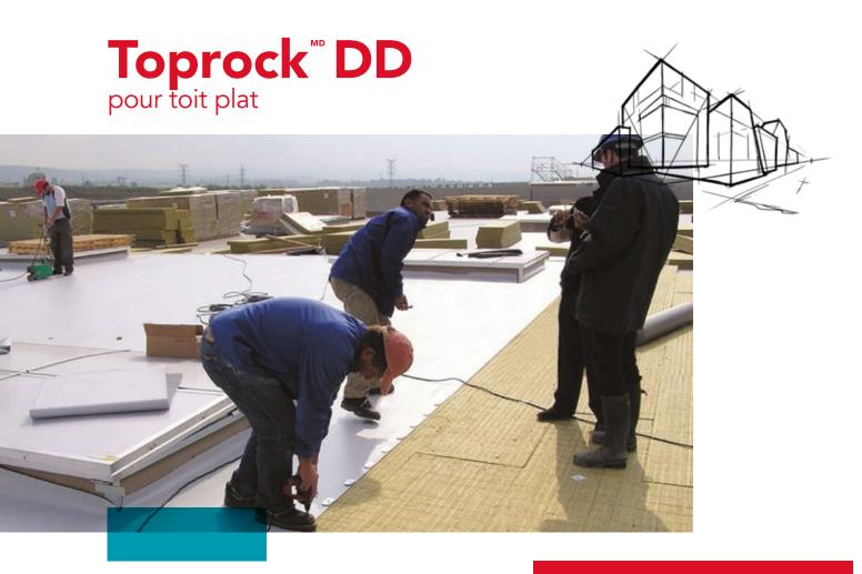
Toprock<sup>MD</sup> DD de ROCKWOOL est un panneau isolant fait de laine de roche de haute densité sans revêtement utilisé pour les toits à faible pente. Toprock<sup>MD</sup> DD est un panneau de substrat qui convient à tous les platelages de toit à faible pente et les systèmes de membrane fixés mécaniquement.
