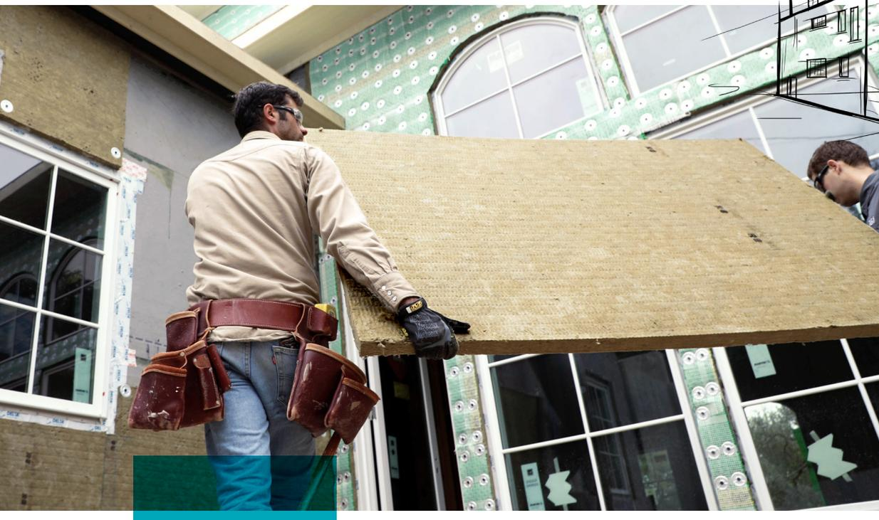
ROCKWOOL Comfortboard<sup>MD</sup> 80 est un panneau d'isolation rigide en laine de roche conçu pour servir d'isolation continue extérieure.
