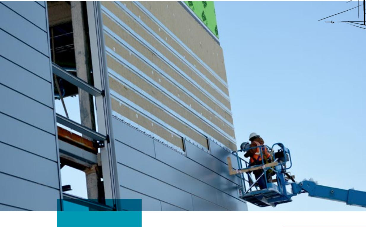
ROCKWOOL Comfortboard<sup>MD</sup> 110 est un panneau isolant rigide en laine de roche à haute densité non combustible conçu comme isolant continu dans les applications commerciales.
