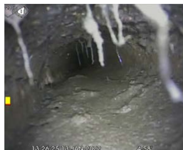
Figuur 8: Voorbeeld van sedimentlaag >2cm
