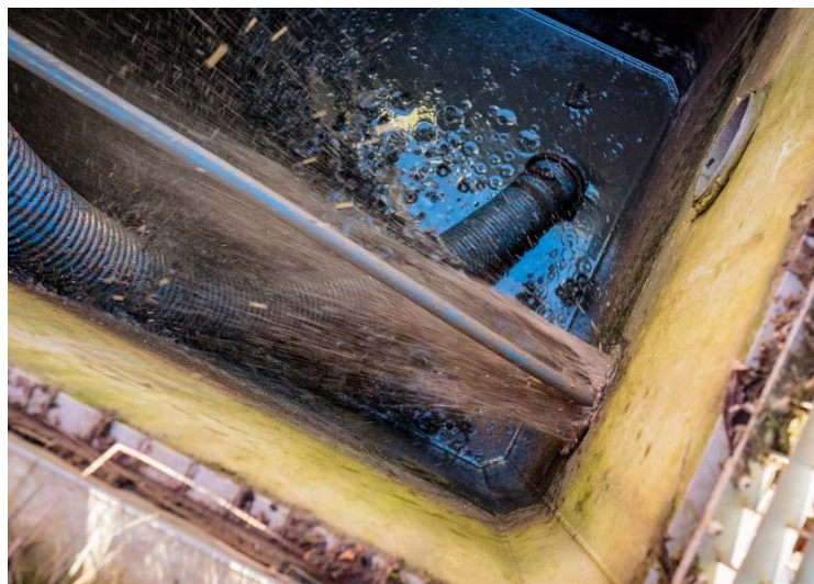
Figur 13: Sediment skubbes ud af kanalen ned i brønden
