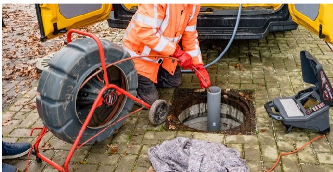
Foto 2: Inspectie via hulpbuis
