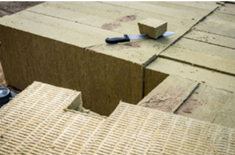
Steinwolle lässt sich leicht mit einem (Steinwoll-)Messer bearbeiten.
