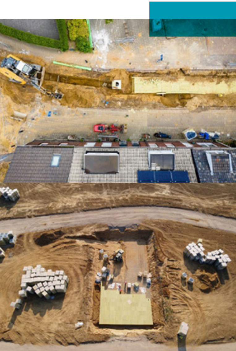
Rockflow angelegt als Sickerleitung (oben) oder zentraler Speicher (unten).
