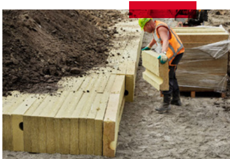
Manuelle Installation von 50 cm hohen Rockflow-Elementen
