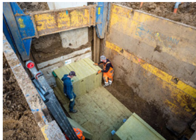
Ein 2 m hohes Rockflow-System, das aus zwei Schichten von 100 cm hohen Elementen besteht.
