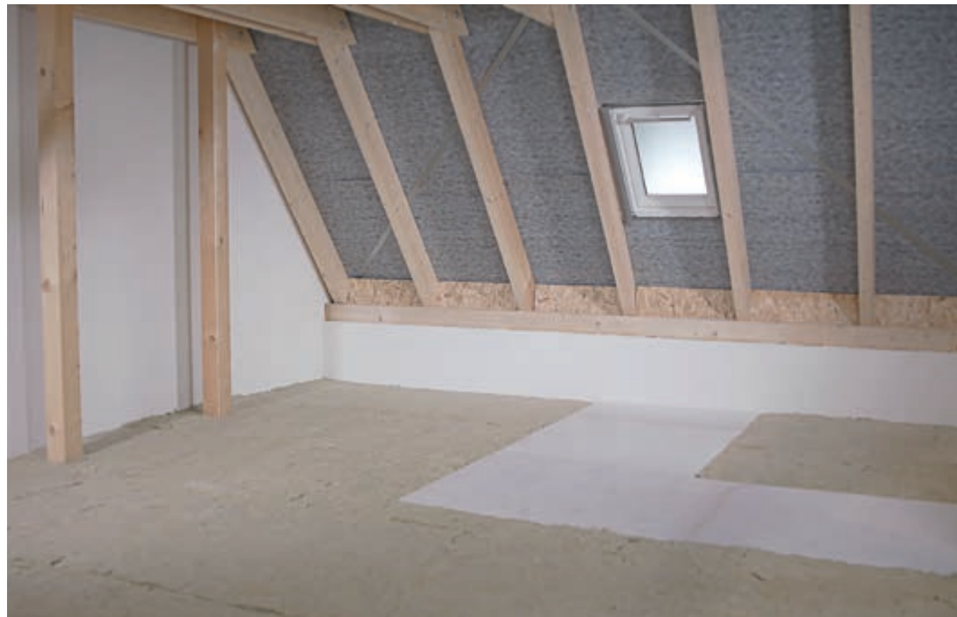
Revisionsweg mit Tegarock Premium – Flächendämmung Varirock 035
