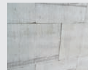
Die Dämmplatte Planarock Paint im Verband verlegt
