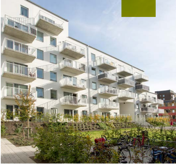
Lindängen, new Tranon buildings. Source: Tranon, Fotografier: Pernilla Wastberg
