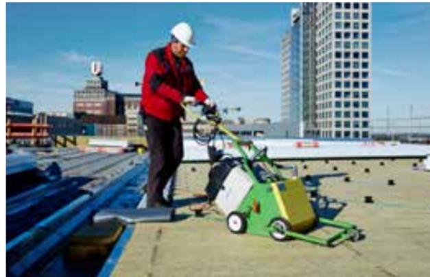
Schneiden der Nuten mit den Prodach-Schneidegeräten
