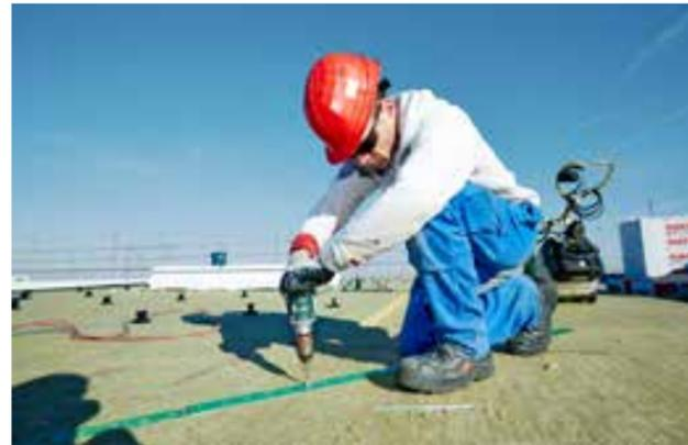
Montage der Prodach-Befestigungsschienen
