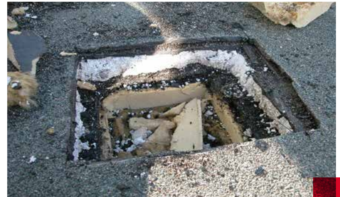
Eine Dachöffnung bringt Gewissheit
