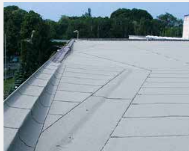
Punktentwässerung entlang der Attika
