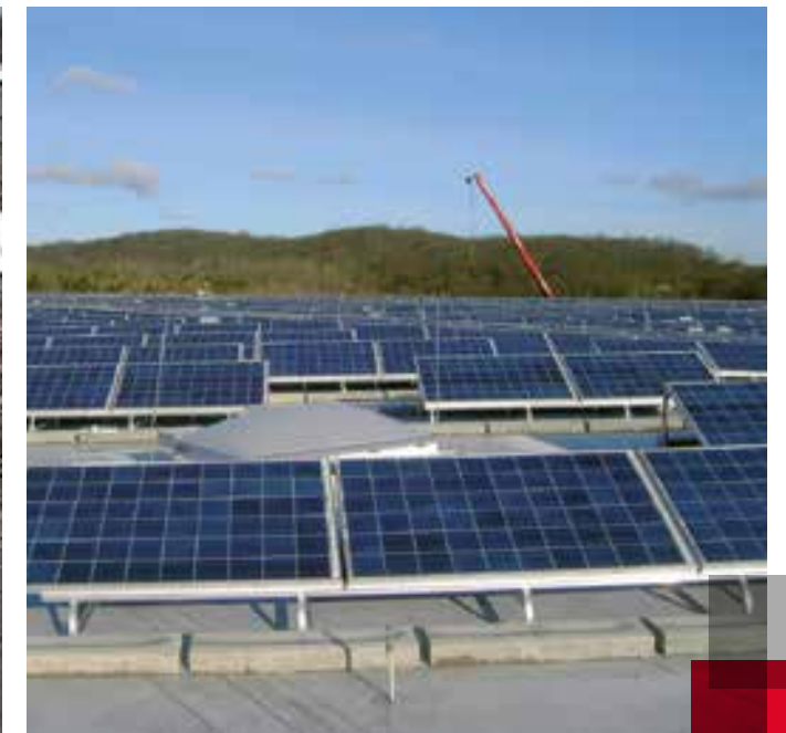
Neue Beanspruchung durch Photovoltaikanlagen
