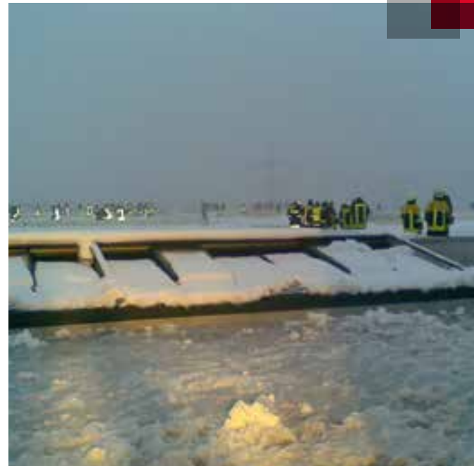
Flachdächer sind extremen Witterungseinflüssen ausgesetzt
