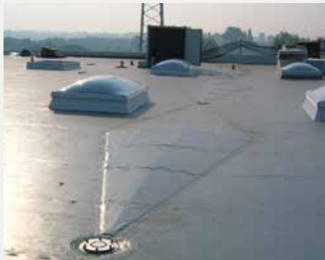
Punktentwässerung entlang der Kehllinien
