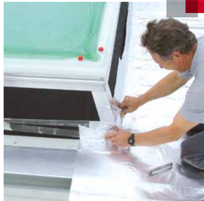
Detailausführung Lichtkuppelanschluss
