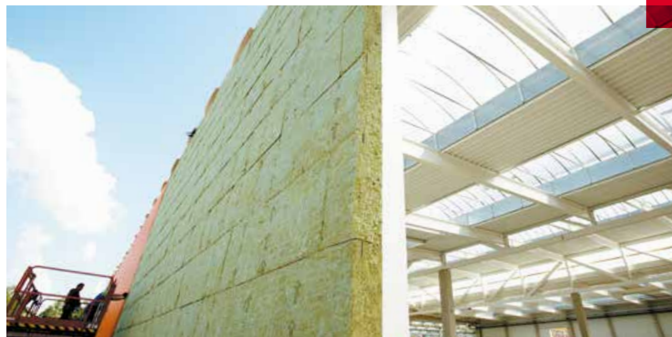
Durch die Dämmstoff-Überdeckung der Metallstege in 40 mm oder 80 mm Dicke sorgt das Steelrock Plus Dämmssystem für eine zuverlässige Reduzierung von Wärmebrücken.
