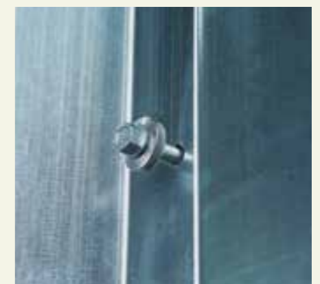
Nur die Außenschale bzw. das Hutprofil wird mit 6,5 mm vorgebohrt.
