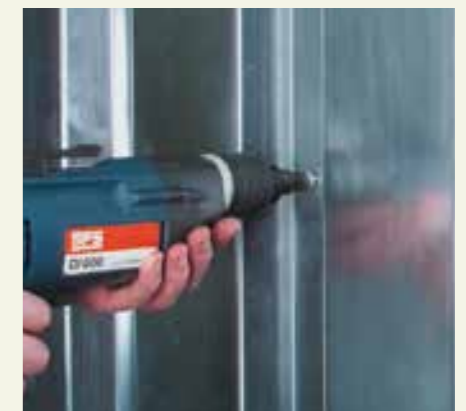
Der Steelrock Plus Distanzbefestiger wird ohne Tiefenanschlag und Drehmomentbegrenzung gesetzt.
