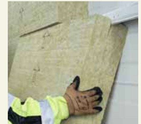
Steelrock Plus wird mit dem Einschnitt zum Obergurt in die Kassetten eingebaut.
